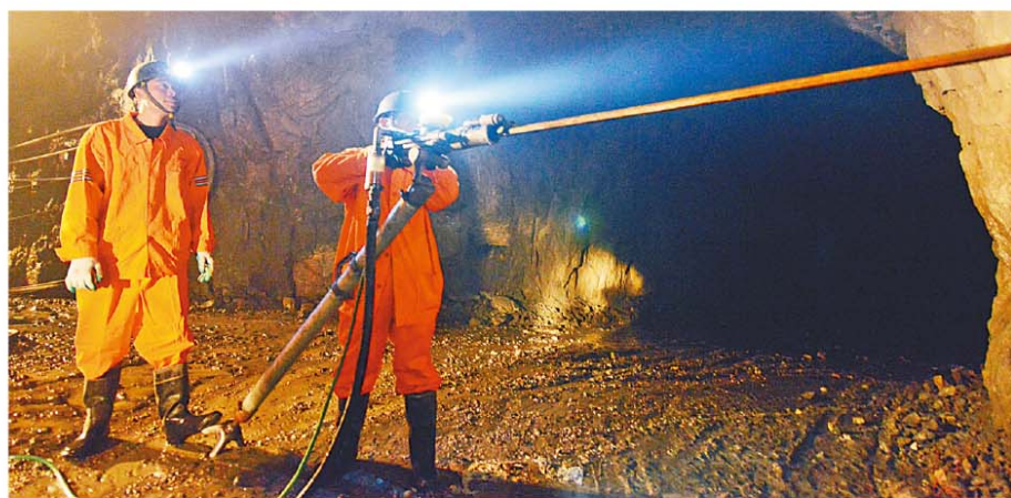
宁安东合矿业井下作业现场
